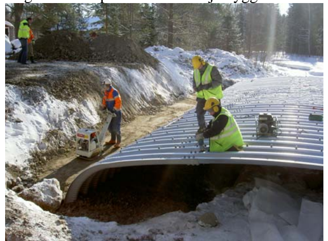
På plats finns en färdig bädd och Gävle Vägtrummors personal kan börja bygga bron
