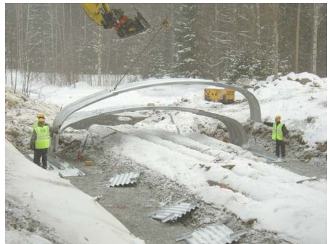
På plats finns en färdig bädd och Gävle Vägtrummors personal kan börja bygga bron
