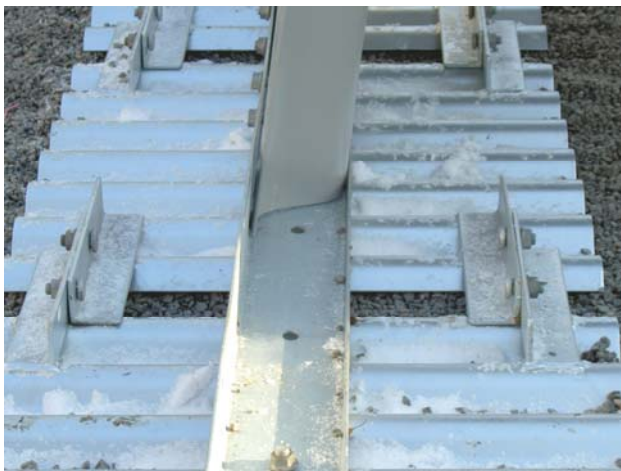
Fundament typ Gävle Vägtrummor MP 150
